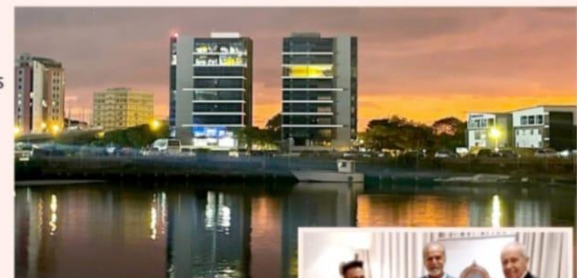
Les deux tours existantes de United Docks.
